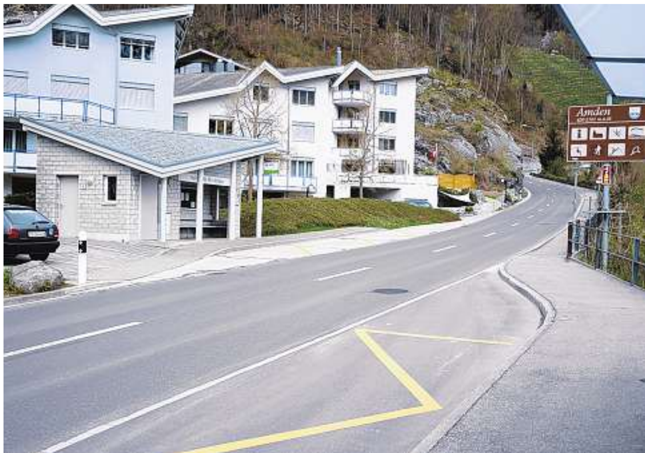
Umstrittene Lösung: Laut Entwurf sollen Zebrastreifen und Mittelinsel auf Höhe der Tafel (rechts im Bild) erstellt werden – die Busbucht (links) würde somit verschwinden und zur normalen Fahrspur.
