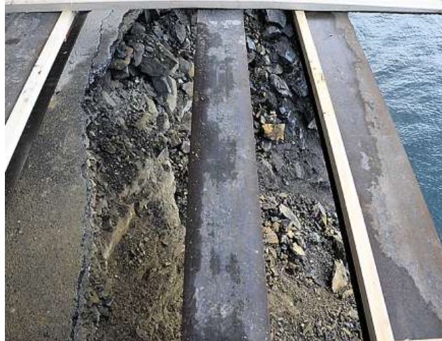
Beeindruckend: Stahlträger überspannen das klaffende Loch in der Betliserstrasse.
