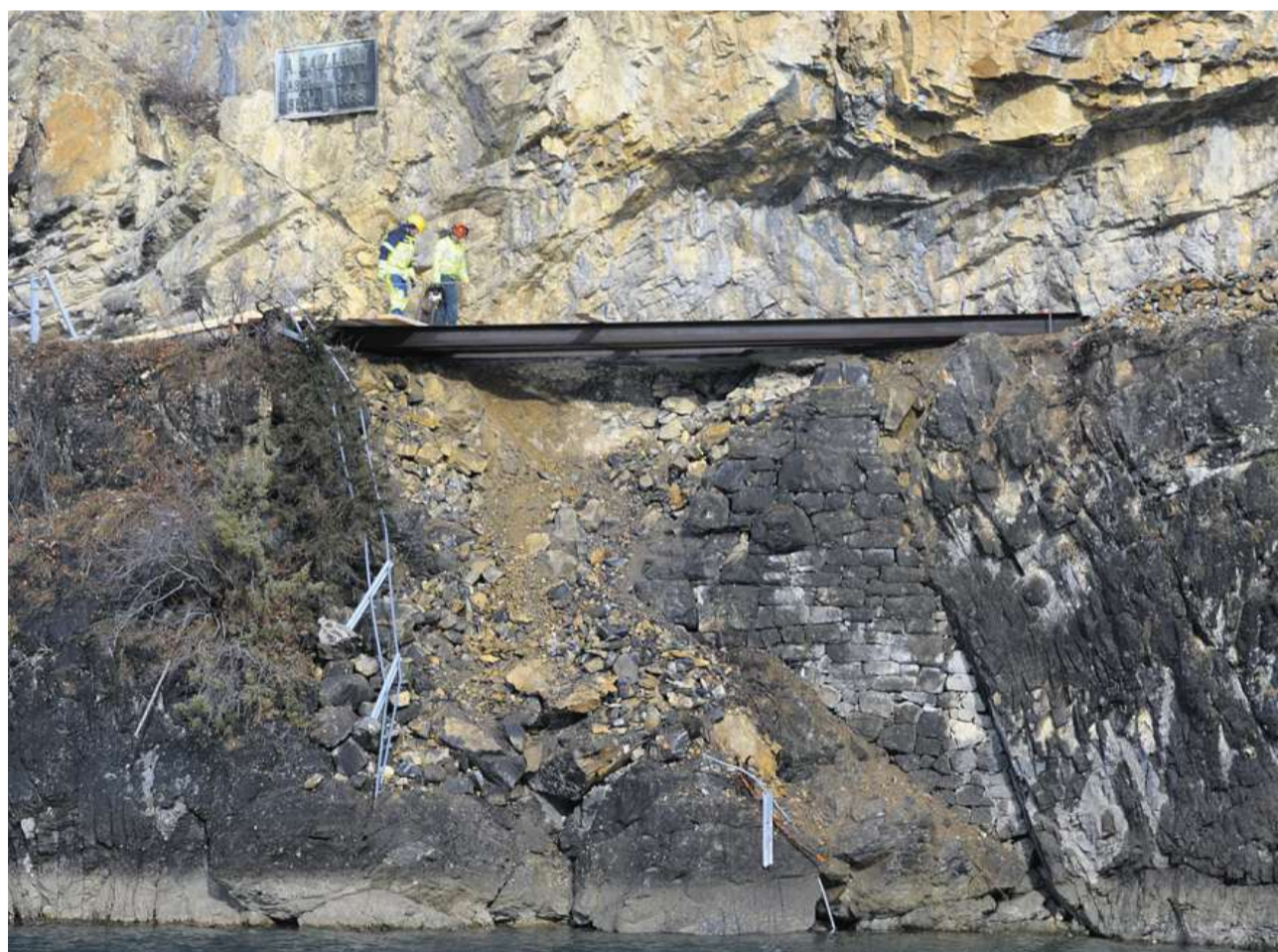
Provisorium: Arbeiter des Ammler Werkhofs setzen die Betliserstrasse mit einer Notbrücke in stand.
