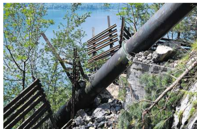
Gefährlich: Die Schutzverbauung ist durchbrochen.
