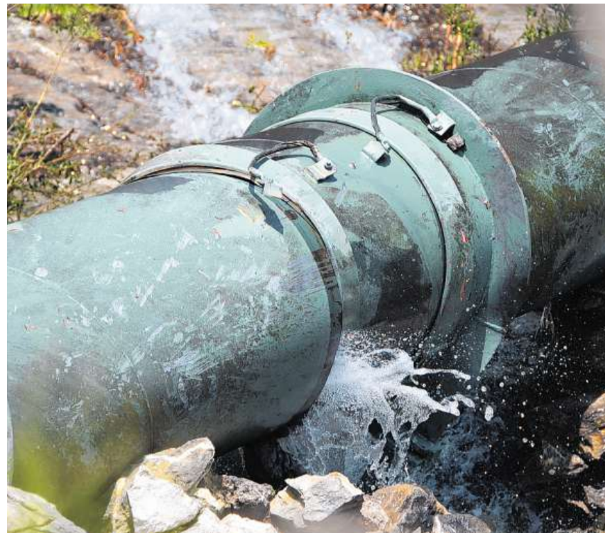
Gewaltige Kräfte: Am steilen Hang über dem Walensee ist die Druckleitung zum Wasserkraftwerk Muslen durch Felsmassen verschoben, eine Schweissnaht zerrissen.
