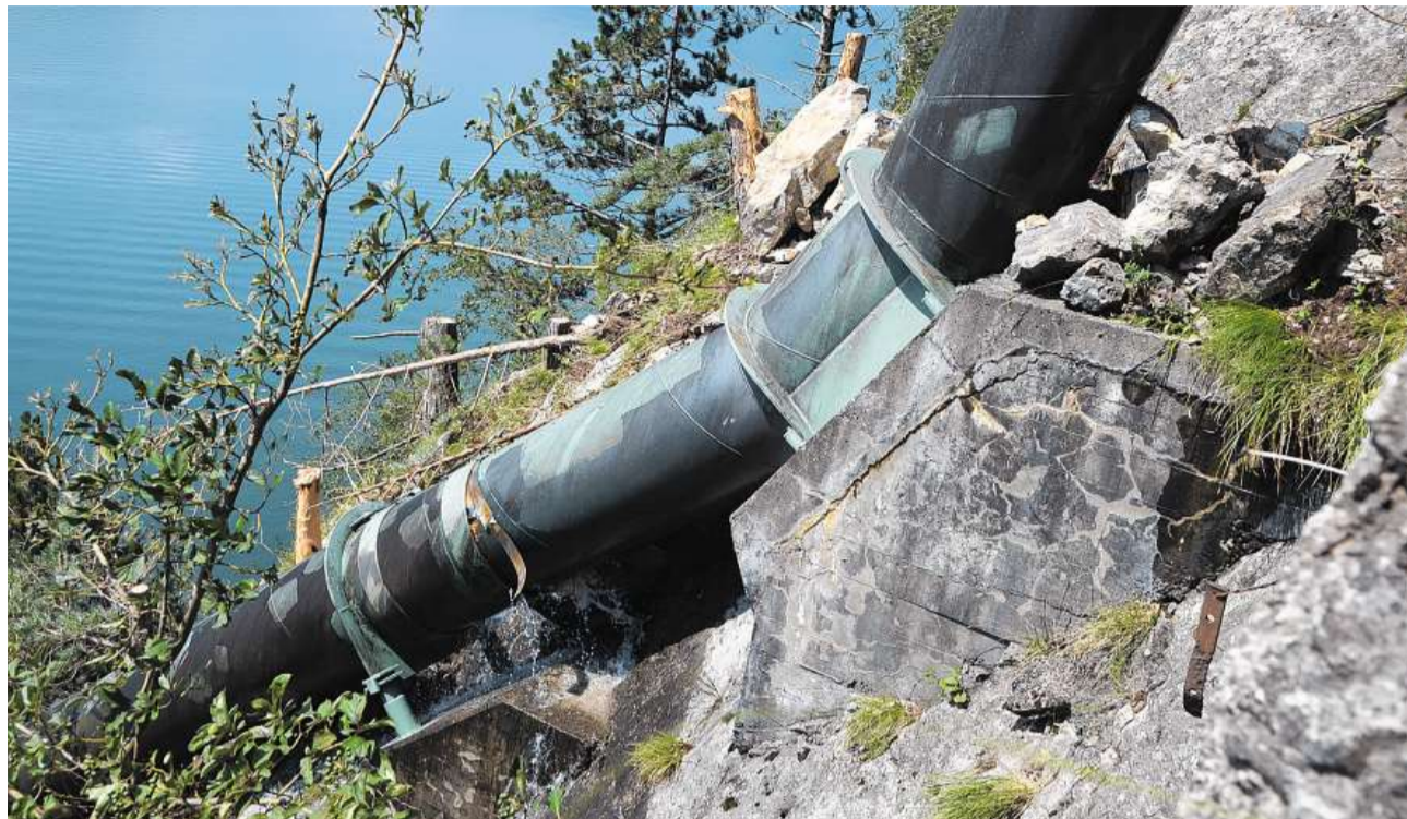
Gewaltige Kräfte: Am steilen Hang über dem Walensee ist die Druckleitung zum Wasserkraftwerk Muslen durch Felsmassen verschoben, eine Schweissnaht zerrissen.
