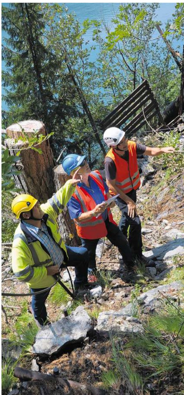
Augenscheinnahme: Experten begutachten das Leck und planen die Reparatur der Druckleitung.
