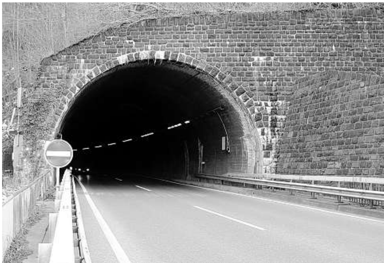
Erneuerungsbedarf: Der Kerenzerbergtunnel wird wohl zu einer der grössten Baustellen.
